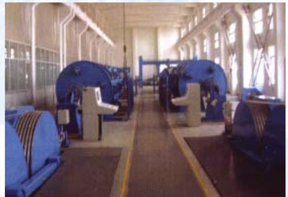
Cabling Line for OPGW
