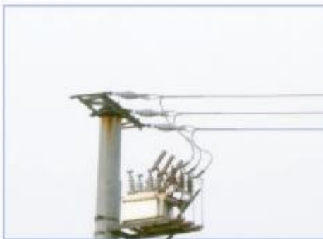
10KV线路终端线路 10KV Line Terminal
